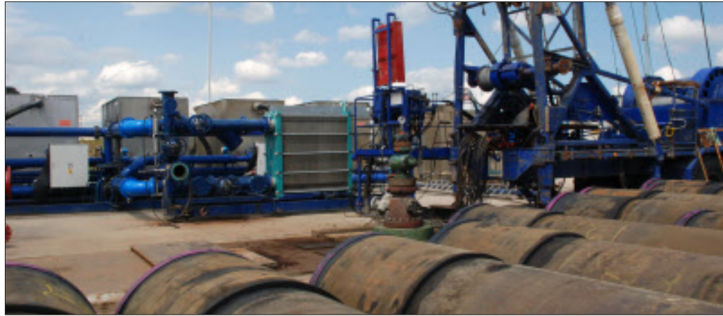
An dieser Stelle werden die Pumprohre eingesetzt.
