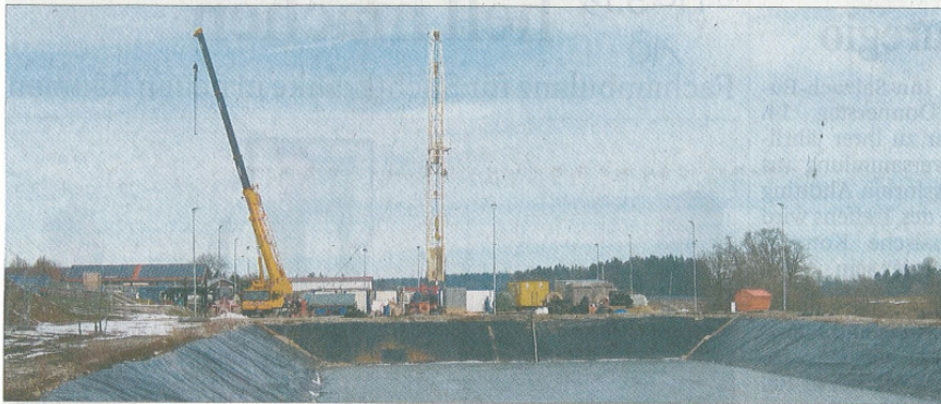
Auf der GEOenergie-Baustelle in Erdlehen beginnen Mitte März wieder die Pumpstests.
